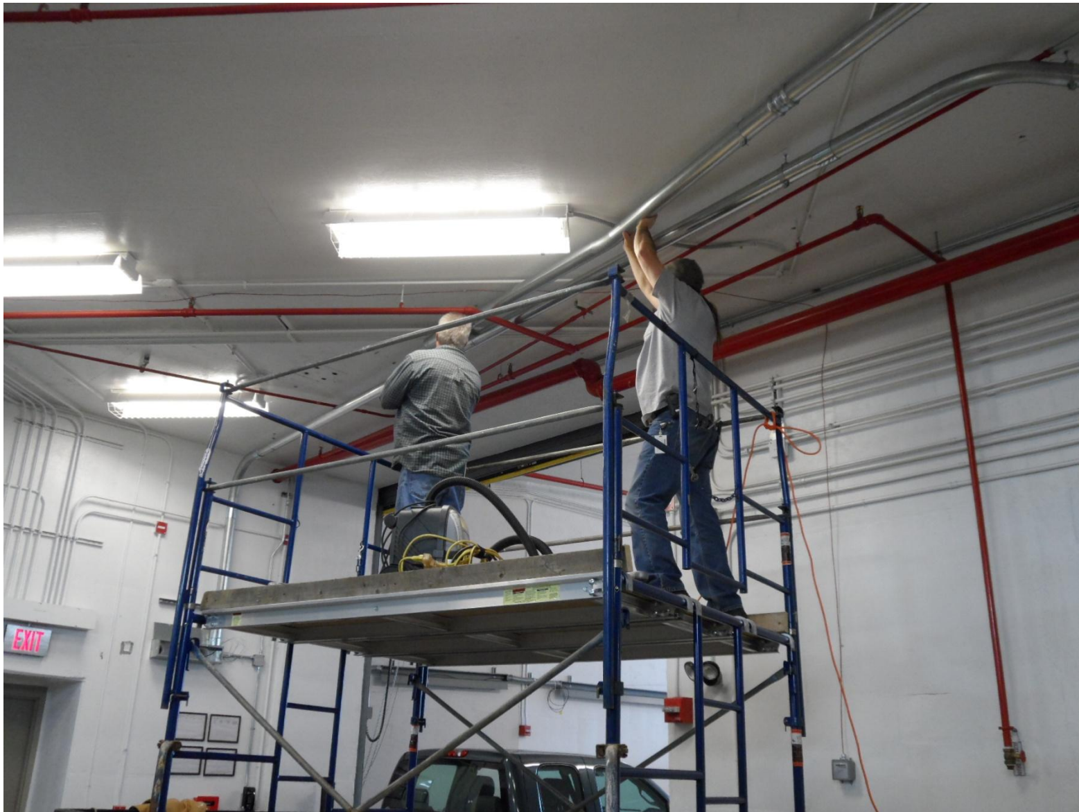
Installing Hall D tagger vault PSS conduits
